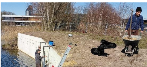
Werken aan de waluwwand
