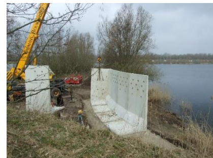
Bouw van de wand in April 2013 en het jaarlijks vullen van de nestgaten
